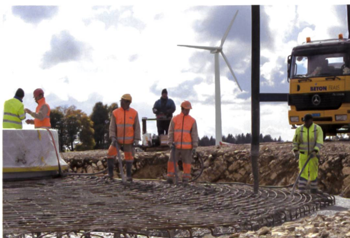
Bild 1. Tausend Tonnen Beton werden in das Fundament gepumpt.
