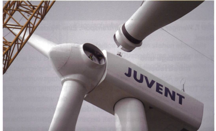
Bild 6. Montage eines Rotorblattes.
