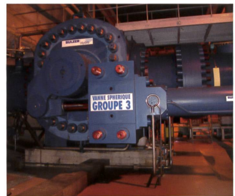
Bild 19. Kugelschieber Bieudron.
