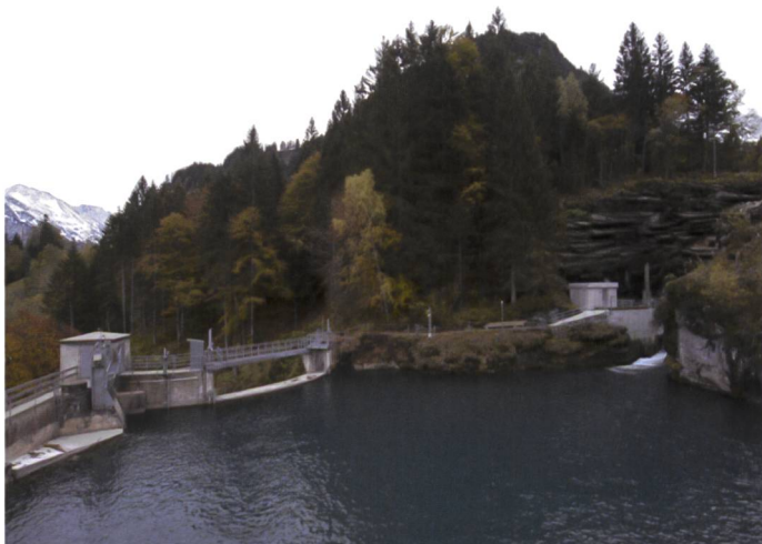
Bild 1. Das Staubecken Zwirgi auf 1000 m ü.M. mit dem Einlaufbecken (rechts) und der Staumauer (links).
