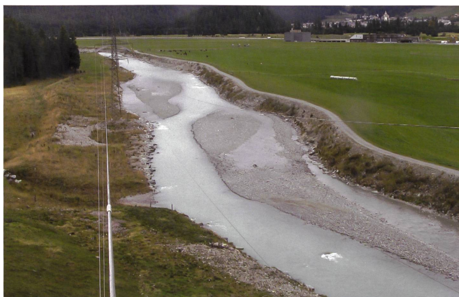
Bild 3. Aufweitung am Flaz bei Samedan [5].
