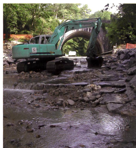
fig. 12. Réalisation d'une rampe à castor dans le cadre d'un aménagement piscicole sur le cours de la Promenthouse, coordonnées: 509 460/140 750.
