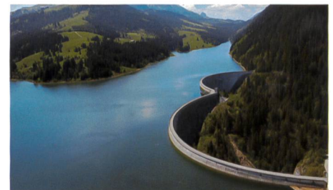
Bild: Bogenmauer Hongrin der FMHL.
