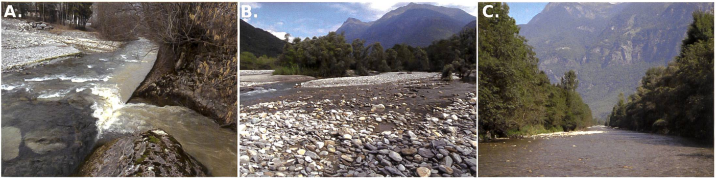
Bild 2. Beispiele für Habitatbeeinträchtigung in Flussökosystemen. A. Die stark verbaute Mündung des Lochrütibachs (Nidwalden) vor der Revitalisierung: der Bach fließt über eine steil abfallende, betonierte Sohle in die Engelberger Aa – ein Beispiel für schlechte Vernetzung. B. Die gut vernetzte Brennoaue bei Loderio (Tessin). Gefangene Fischarten im April 2010: Bachforelle, Groppe, Alet, Südströmer, Elritze. C. Ein an die Brennoaue angrenzender, kanalisierter Flussabschnitt oberhalb mit den nachgewiesenen Fischarten Bachforelle und Groppe. Einher mit der Habitatdegradierung durch die Kanalisierung geht ein Verlust von Fischarten. Fotos: A: Armin Peter, B-C: Denise Weibel.
