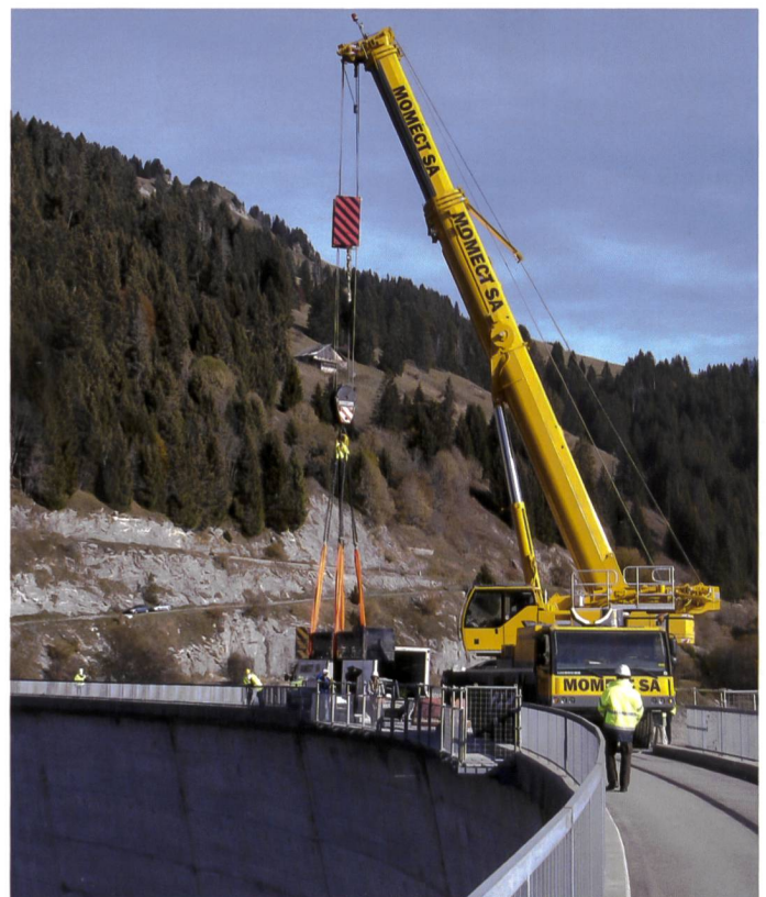
Figure 7. 29 octobre 2009: Essai de levage à 28 t sur le couronnement Nord, qui confirmait les concepts théoriques in situ.
