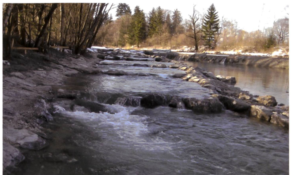
Aufstiegsanlage am Wehr Schönmühl/Loisach (Quelle: E-ON).
