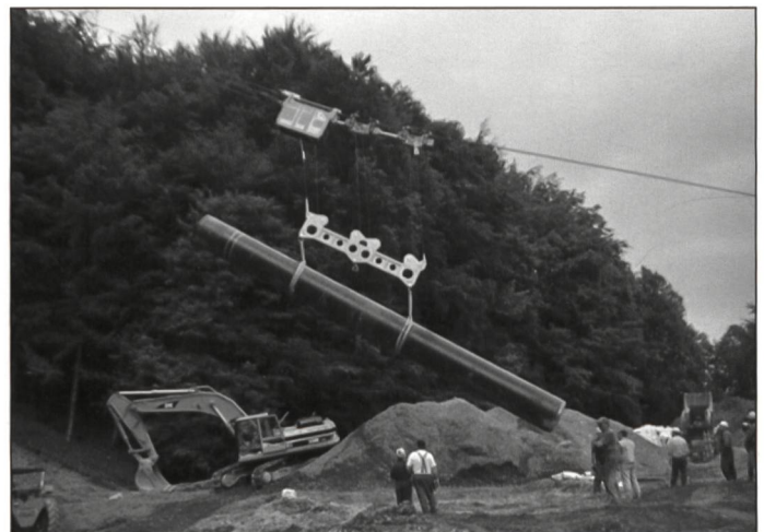
Transport und Versetzen Erdgasleitung, Rohrgewicht 12 Tonnen
