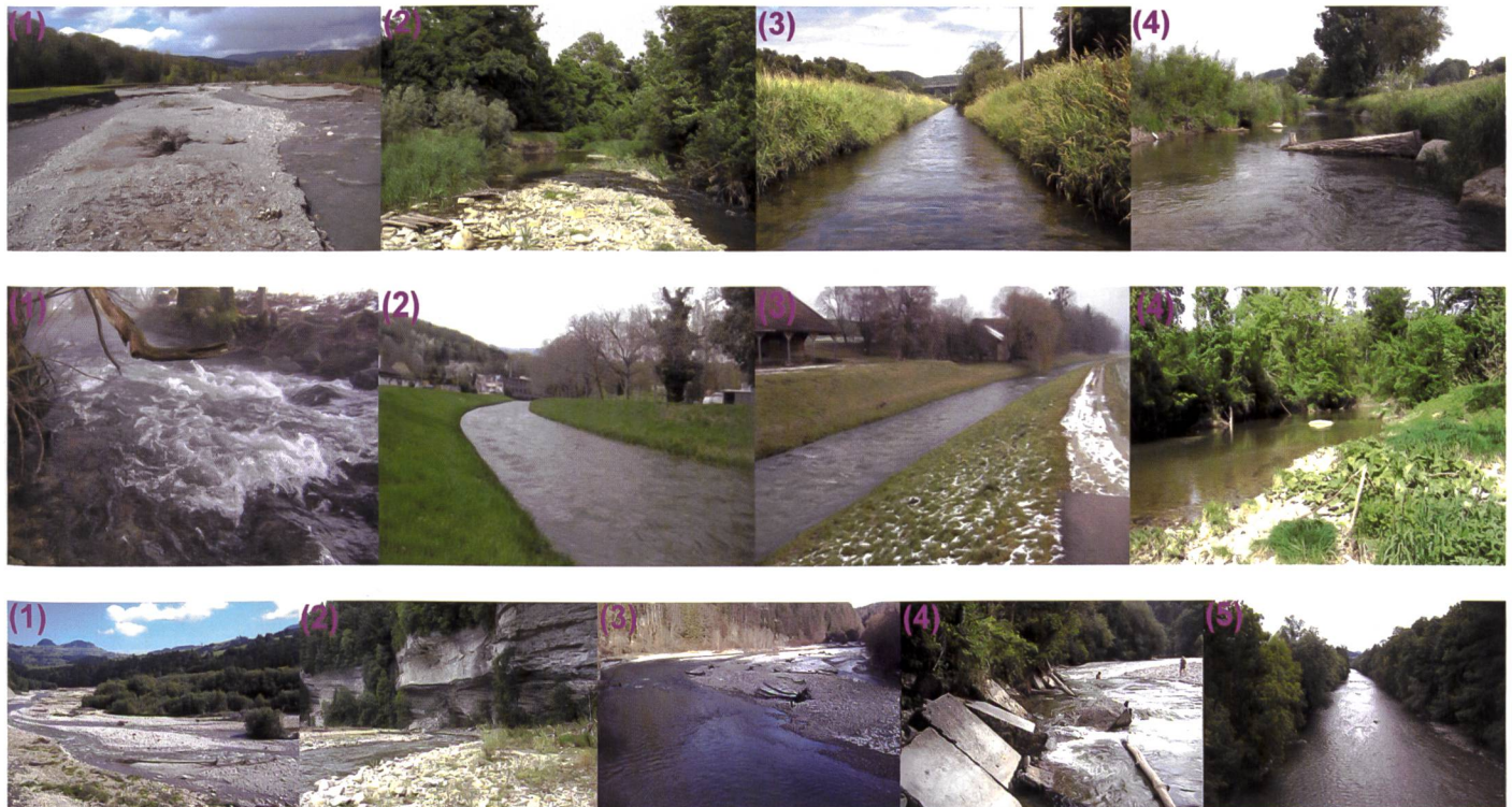
Bild 3. Aufnahmen der Untersuchungsabschnitte. Bünz (oben): (1) durch Jahrhunderthochwasser 1999 geformtes pendelndes System («Bünzau»), (2) naturbelassen pendelnd, (3) kanalisiert, (4) revitalisiert.
