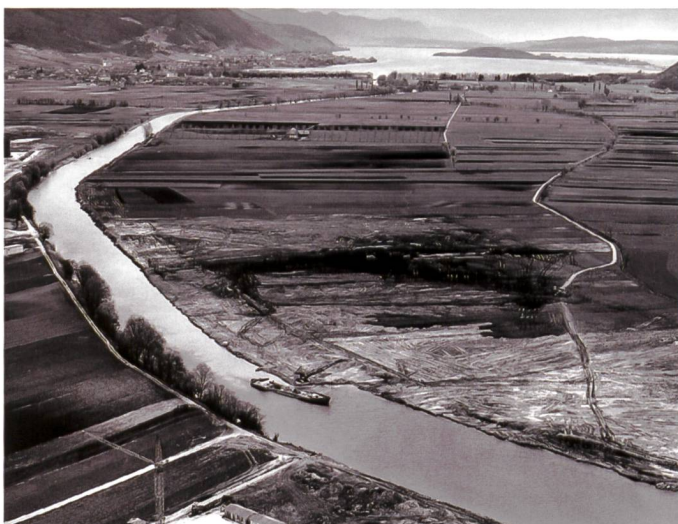
Bild 8. Verbreiterung des Zihlkanals zwischen Neuenburger- und Bielersee (oben) während der Zweiten Juragewässerkorrektion. (archiv suzanne muller).
