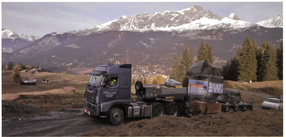
Bild 1. Anlieferung des 30 Tonnen schweren Generators von Savognin zur neuen Kraftwerkszentrale Nandrò (Quelle: ewz)
