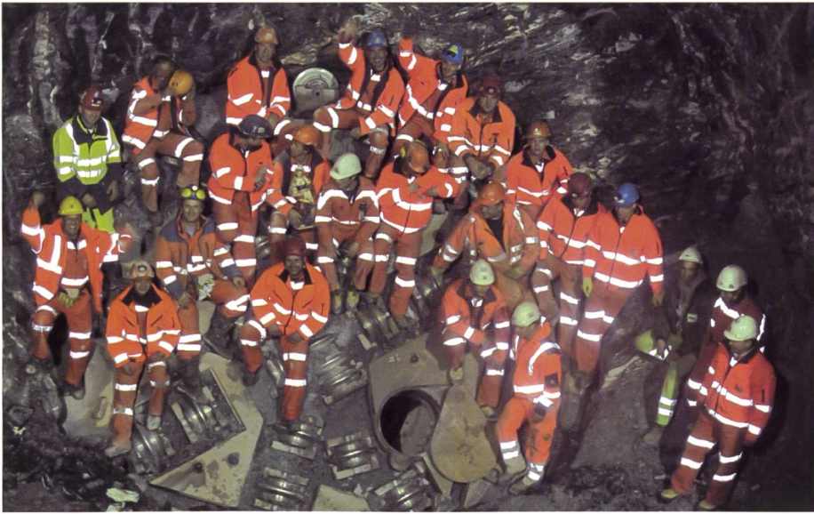
Bild. Bohrmannschaft nach dem Durchschlag Mitte Oktober 2011 (Quelle: Axpo).
