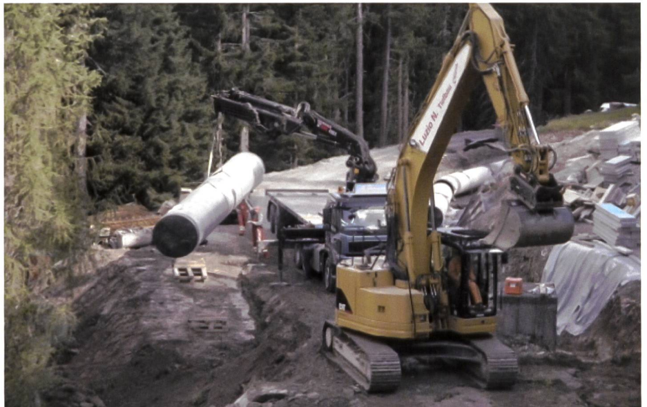
Bild 2. Einbringen der druckfesten Stahlleitung (Quelle: ewz)
