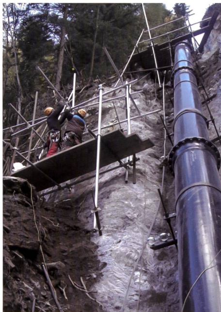
Bild 3. Arbeiten zur Befestigung der Druckleitung in schwierigem Gelände.
