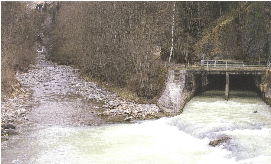
Bild 3. Unteres Gadmerwasser bei der Wasserrückgabe vom Kraftwerk Innertkirchen 1. Mit der künftigen Verlegung der Wasserrückgabe (unter dem Gadmerwasser hindurch) und einer weiteren Erhöhung der Restwassermenge steht dieser Gewässerabschnitt (links im Bild) künftig als Laichstrecke für die Seeforelle wieder zur Verfügung.
