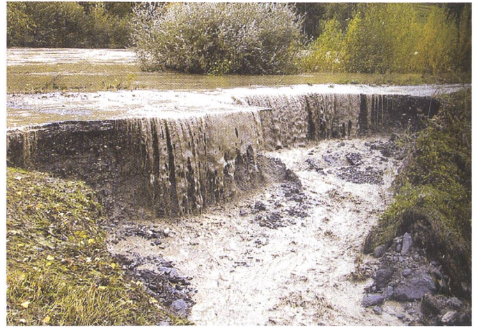
Bild 3. Dambruch bei Biedron VS an der Rhone während des Hochwassers vom 15. Oktober 2000 (Aufnahme Grande Dixence SA).
