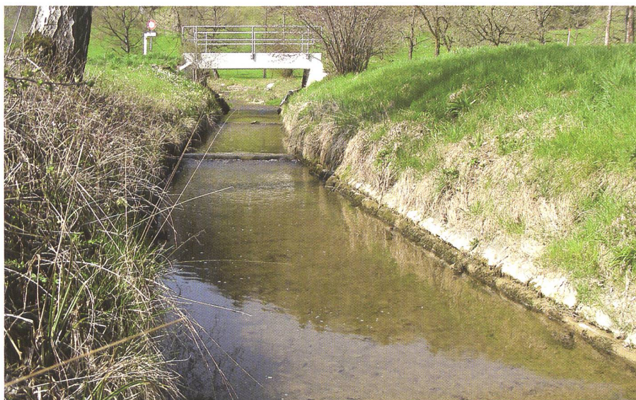
Bild 12. Hell, kanalisierter Abschnitt.
