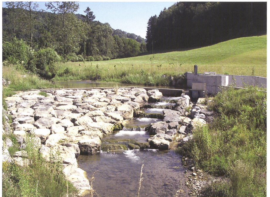
Bild 6. Wehr und Rampe der Wasserfassung Aumüli: Niederwasser fliesst im Fischaufstieg.
