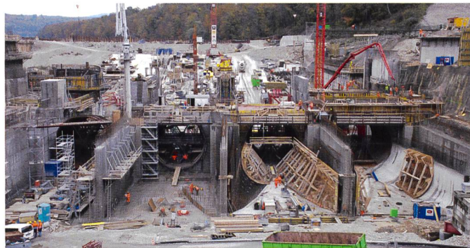
Bild 5. Unterwasserauslauf Saugrohrstrukturen Maschinen 1-4.
