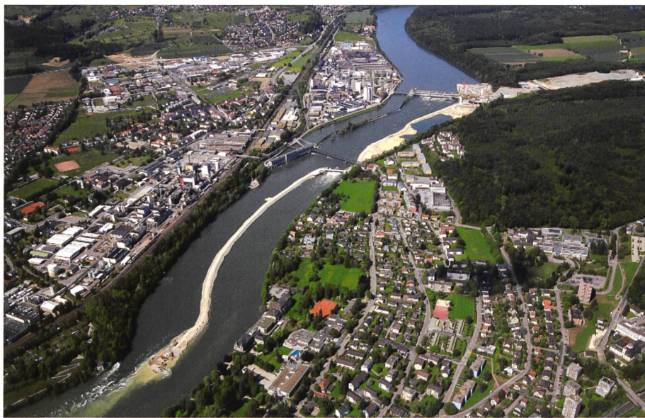
Bild 1. Unterster Punkt der Rheineintiefung im Mai 2009.
