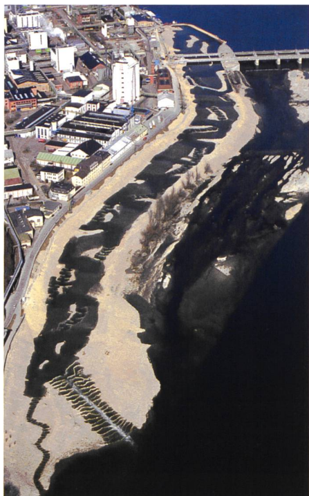
Bild 16. im ehemaligen Kraftwerkszu- laufkanal.
