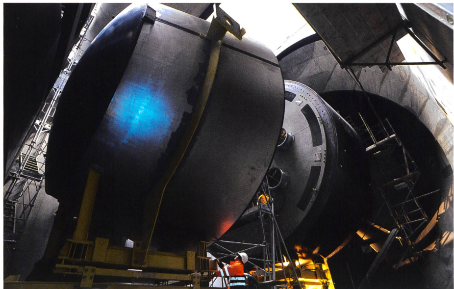
Bild 10. Zusammenschieben des Generatorstators über den Rotor.
