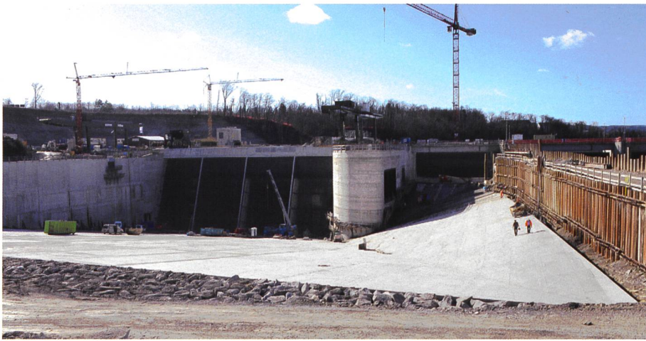
Bild 11. Blick auf den Zulauf des Kraftwerks kurz vor der Flutung der Baugrube.
