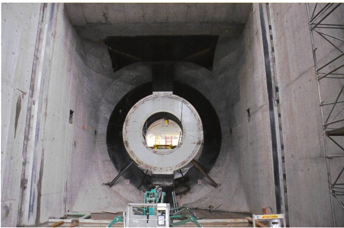
Bild 6. Der Stützringschacht ist eingebaut und die Montagen von Turbine bzw. Generator kann beginnen
