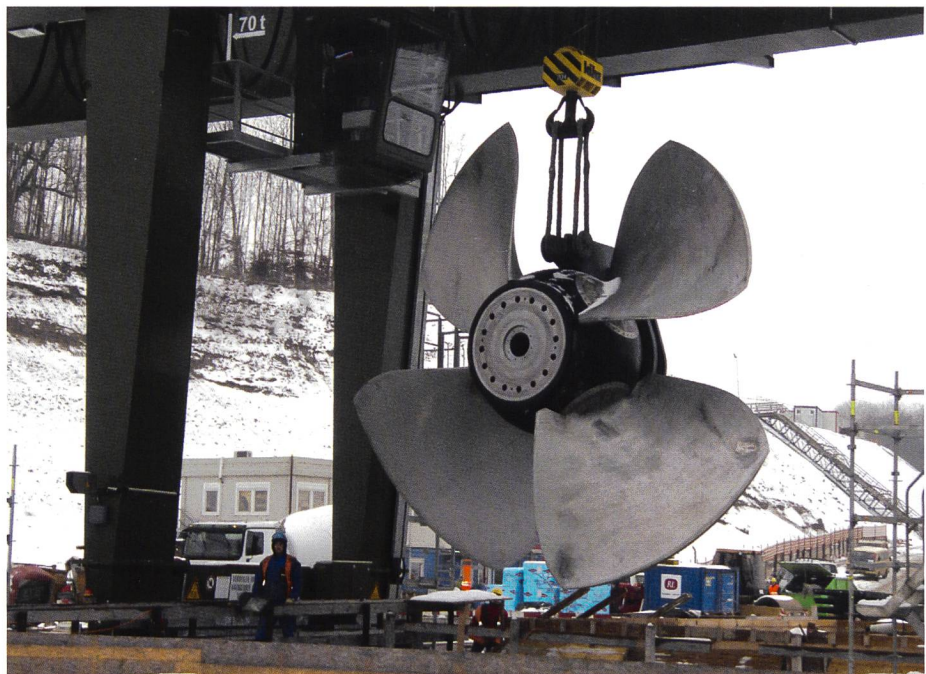
Bild 9. Einheben des ersten Turbinenlaufrades.
