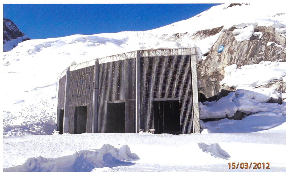
Bild 5. Fassungsbauwerk am Bestimmungsort im Frühjahr 2012 (Foto: Ndd).
