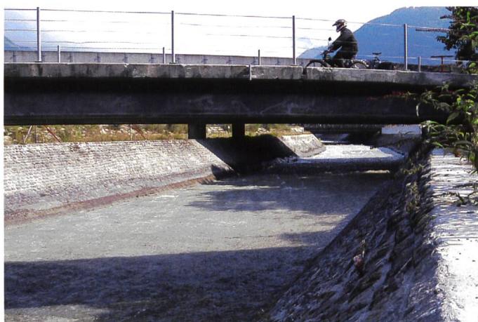
Bild 2. Schächen bei Altdorf (Quelle: Flussbau AG SAH).
