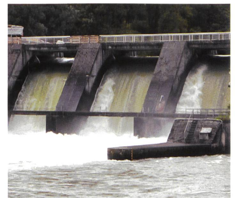
Bild. Abfluss über Wehrklappen beim KW Bremgarten-Zufikon (AEW).
