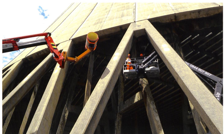
Bild 2. Ersatz der defekten Rohrverbindungen.
