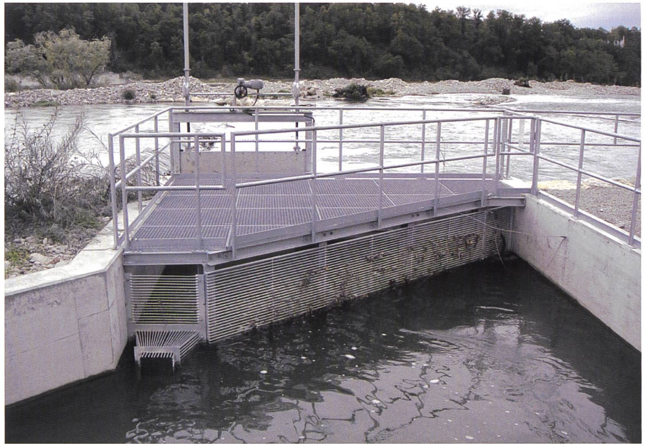
Bild 1. Zählbecken im Umgehungsgewässer KW Reinfelden (Foto: SWV/Pfa).
