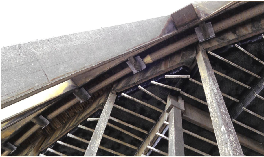
Bild 3. Die neu installierte Winterringleitung mit der Abstützkonstruktion und STRAUB-FLEX Rohrverbindungen.
