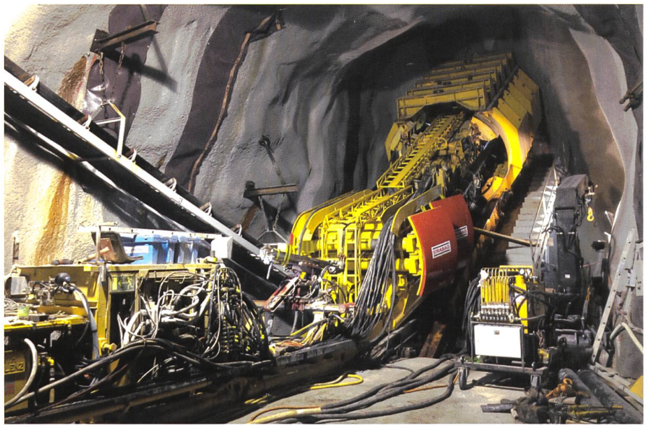
Bild. Tunnelbohrmaschine (KWO).
