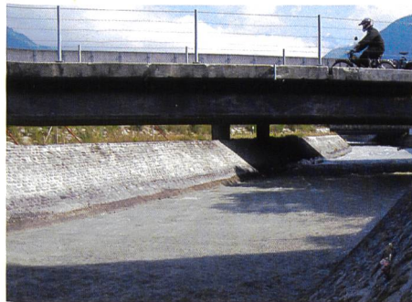
Figure 2. Ruisseau de Schächen au niveau de la commune d'Altdorf (Photo: Flussbau AG SAH).
