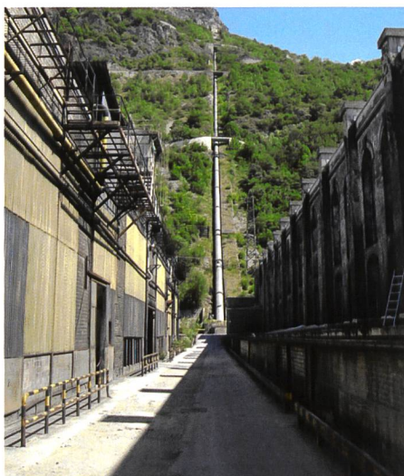
Bild 1. Triebwasserleitung zu dem 1908 für die damalige Aluminiumherstellung gebauten Kraftwerk Navizence bei Chippis/VS (Foto: Pfa).
