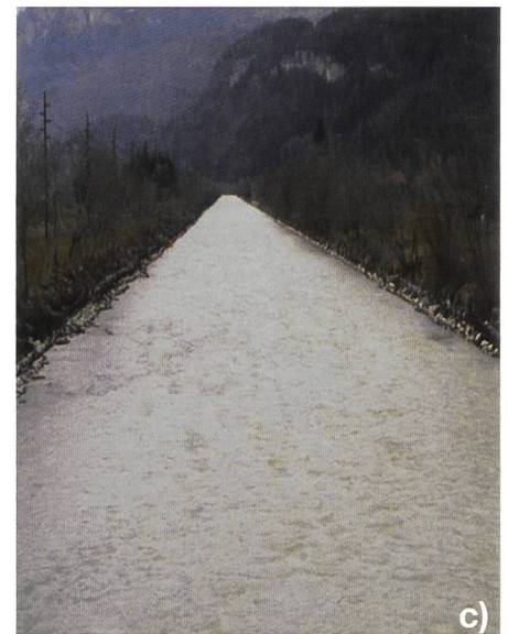
Bild 1. Die Hasliaare: Bühnen- (a), Kiesbank- (b) und Kanalstrecke (c). Im Rahmen der Hochwasserschutzprojekte «Innertkirchen» und «Meiringen bis Brienersee» sowie im Zuge des Investitionsprogramms KWO plus (Schweizer et al., 2012b) sind verschiedene morphologische Aufwertungen in der Hasliaare geplant. Dabei handelt es sich u.a. um grössere Flussaufweitungen, Absenkungen der Vorländer und Förderungen zur Ufer- und Gewässerstruktur.
