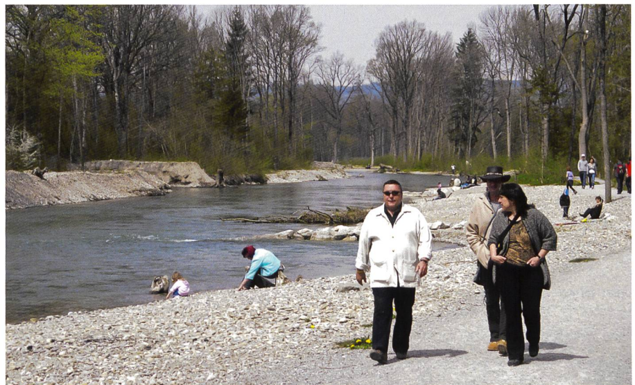
Bild 3. Hochwasserschutzprojekt Aare Thun–Bern. Lokal ist auch die Verbesserung des Erholungswertes und der Erholungsinfrastruktur ein Ziel.
