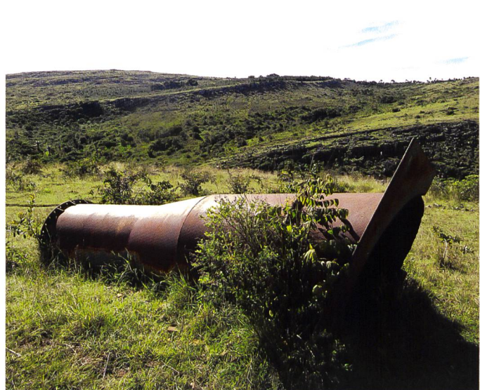
Bild 9. Einlaufrohr des Vorgängerprojektes.
