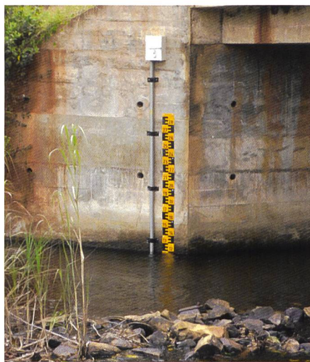
Bild 3. Neu errichtete Abflussmessstation am Fluss Kamwana.
