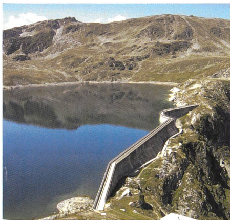
Bild. Speicher als zentrales Element der Versorgungssicherheit (Foto: Argessa AG).
