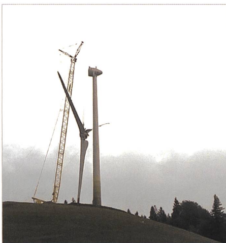
Bild 1. Montage der Rotorblätter und Nabe (Foto: CKW).
