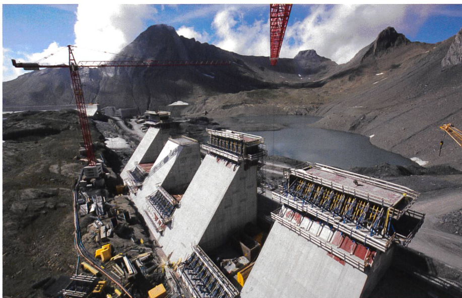
Bild 3. Pilgerschrittverfahren beim Bau der Mauer (Quelle: Axpo, Foto: Daniel Boschung, 2013).
