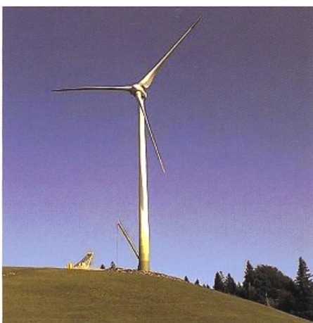
Bild 2. Fertiggestelltes Windkraftwerk (Foto: CKW).
