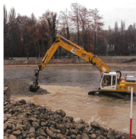
Bild. Lokale Ufersicherung mit Blöcken (Foto: zvg).
