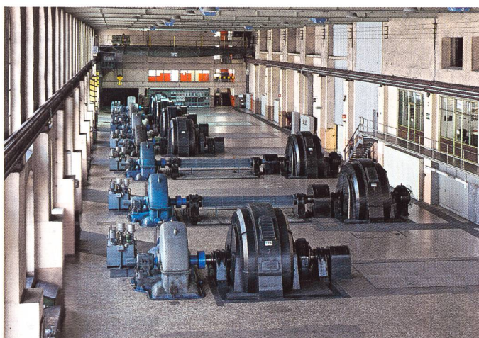
Figure 3. Vue de la salle des machines et des sept groupes Pelton à axe horizontal de la centrale de la Navizence (parties Sud à gauche et Nord à droite); photo: M. Martinez.
