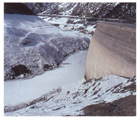
Bild 1. Aussergewöhnlich tiefer Wasserstand im Stausee Livigno im März 2013 (Foto: SNP/R. Haller).
