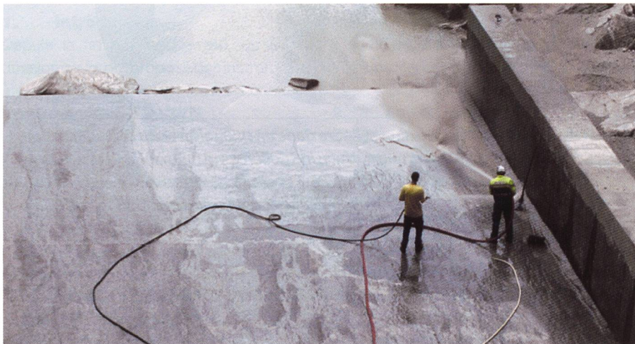
Figure 9. Nettoyage de la rampe de déversement avant numérisation.
