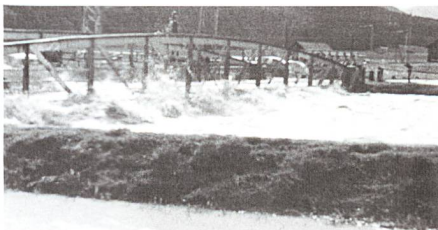
Bild 2. Das Hochwasser von 1956 zeigt, wie überlastete Systeme das Schadensausmass erhöhen.
