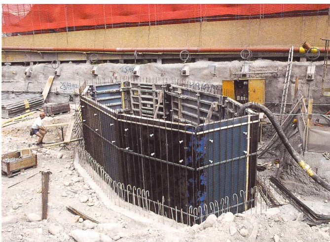
Bild 9. Die spezielle, bei der Brücke für die Rhätische Bahn angewendete Senkkasten-Fundation.
