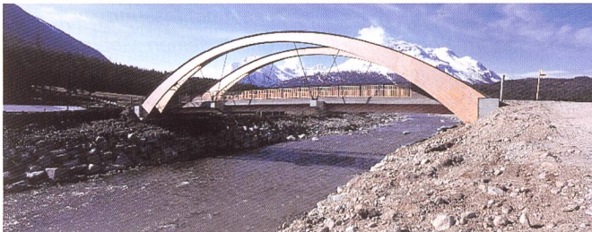
Bild 8. An Kunstbauten mussten unter anderem nicht weniger als fünf Brücken erstellt werden.
