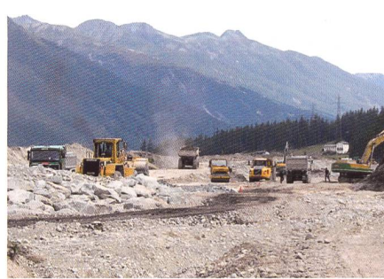
Bild 6. Ein Mammutbauvorhaben dieser Dimensionen bedingt einen hohen Mechanisierungsgrad.
