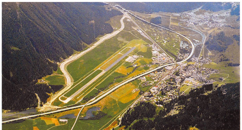
Bild 3. Baustelle riesigen Ausmasses: Der neue Flazlauf oben entlang dem Berg Muotatas Muragl.
