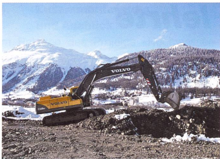
Bild 4. Als die Baumaschinen auffuhren, konnte man sich das Endresultat noch kaum vorstellen.
