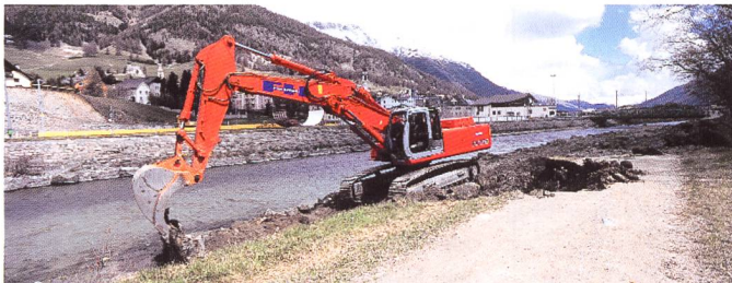
Bild 7. Ohne die Kraft starker Maschinenarme wäre die Rekordbauzeit nicht möglich gewesen.
