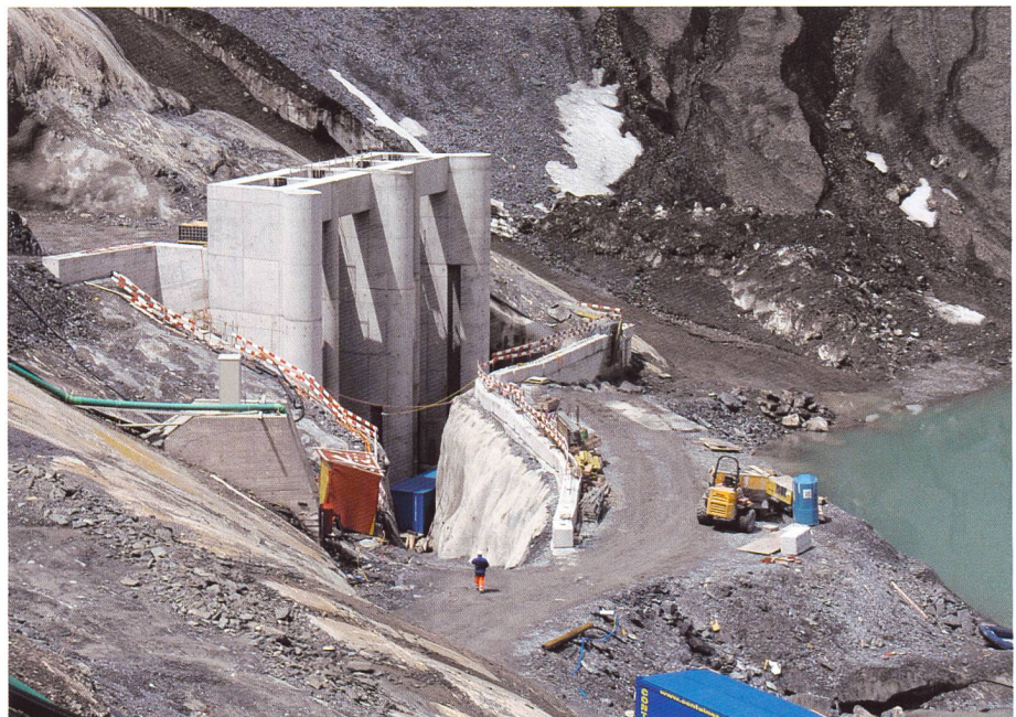
Bild 3. Ein- und Auslaufbauwerk im Stausee Mutt des Pumpspeicherwerkes Limmern Linthal 2015 (Foto Schleiss, Juli 2013).
