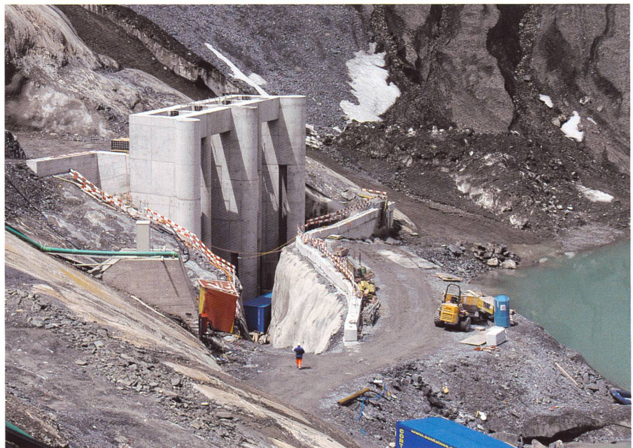
Bild 3. Ein- und Auslaufbauwerk im Stausee Mutt des Pumpspeicherwerkes Limmern Linthal 2015 (Foto Schleiss, Juli 2013).
