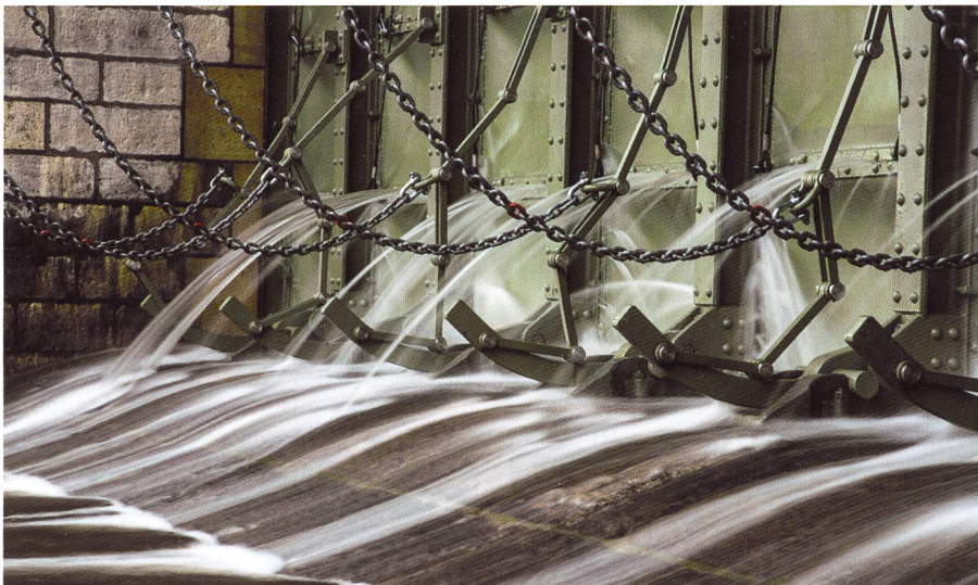
Bild 4. Das Wehr mit neun 12.50 m breiten Wehrröffnungen.
