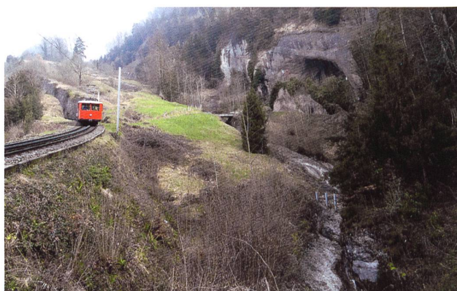
Bild 2. Plattenbach im Bereich kurz vor dem Durchlass Bahndamm VRB mit Blick auf den Bereich «Platte». Das Gerinne verläuft in diesem Bereich mehrheitlich eingeschnitten im Fels.
