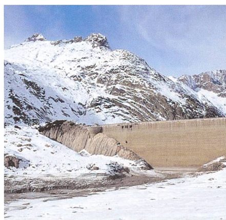
Bild 1. Mitten im entleerten Räterichsbodensee (Foto: KWO).
