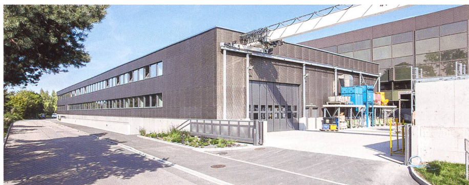
Bild 1. Versuchsanstalt VAW am Höggerberggring 26 auf dem ETH-Campus Höggerberg, Anlieferung, Entstaubungsanlage und Lagerstätte auf dem Vorplatz Süd.
