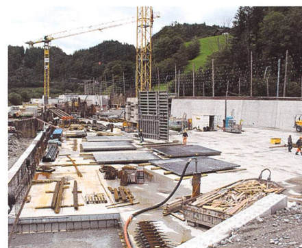
Bild 3. Laufender Bau des Beruhigungsbeckens in Innertkirchen (Foto: SWV/Pfa).
