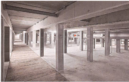
Bild 3. Infrastrukturgeschoss unterhalb der Versuchshalle mit abgedecktem Rücklaufkanal und Stichleitung im Hintergrund.
