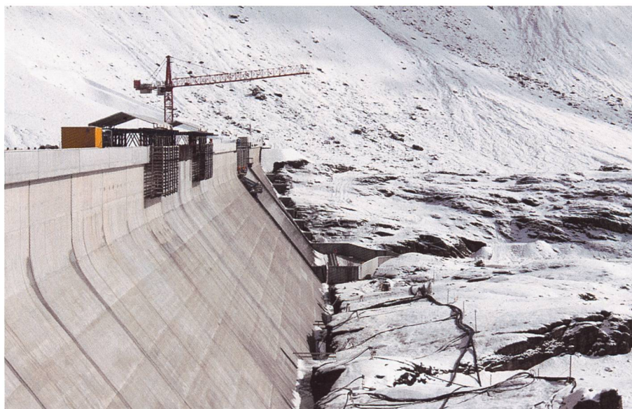
Bild 2. Letzte Arbeiten an der Hochwasserentlastung der neuen Mauer (Foto: SWV/Pfa, Oktober 2014).
