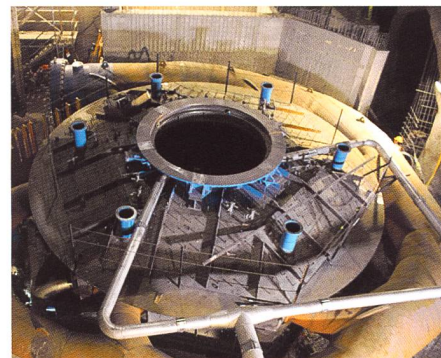
Bild 2. Einbau Peltonturbine in neuer Zentrale Handeck 3 (Foto: SWV/Pfa).
