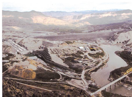
Bild 4. Anlage Illisu, Türkei.
