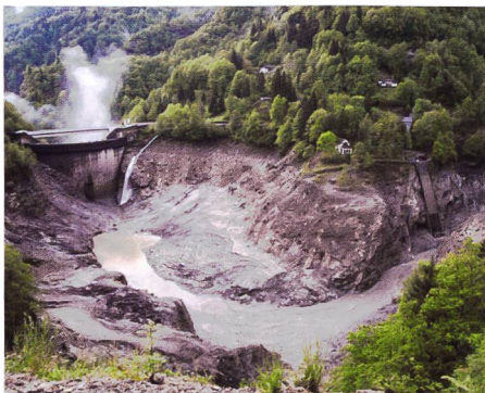
Foto 4. Spurgo del bacino di Palagnedra A novembre 2014, la visita di cantiere per la sistemazione e la rivitalizzazione del torrente Roncaglia a Novazzano si è svolta sotto la pioggia (foto 5).
