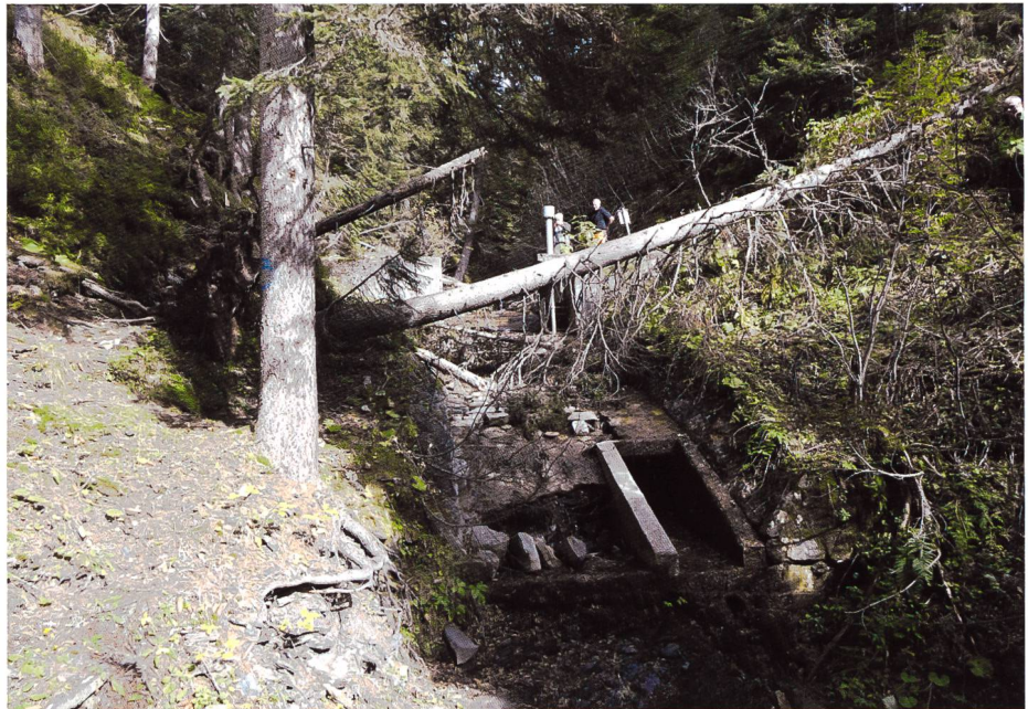
Bild 1. Die Wasserfassung am Moosbach im Herbst 2012.
