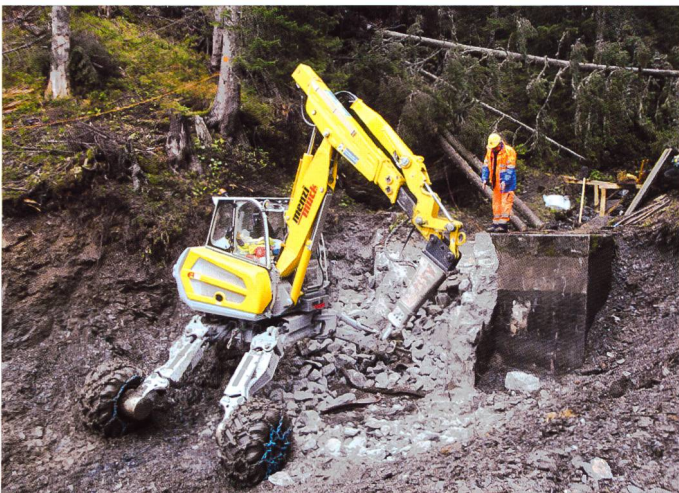
Bild 4. Abbrucharbeiten an der Wasserfassung des Moosbachs im September 2013.
