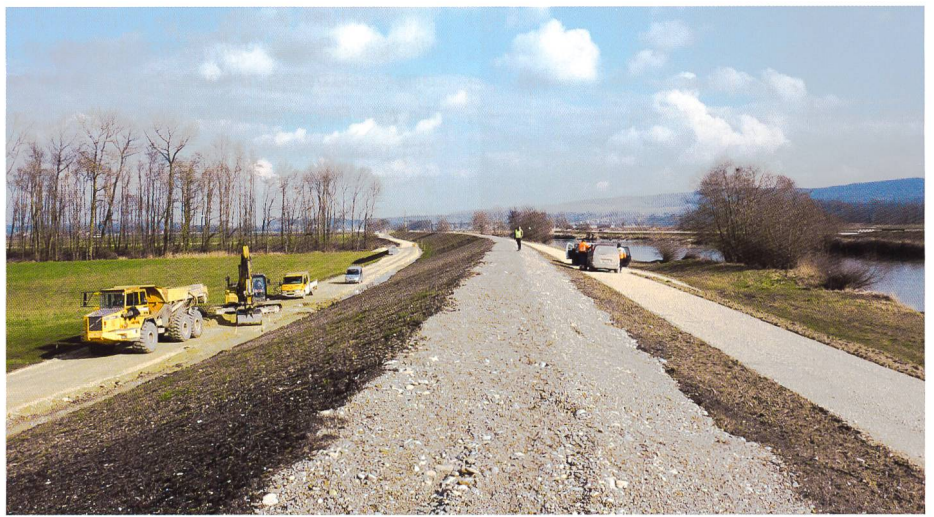
Bild 1. Erhöhter und verstärkter Hochwasserdamm am Hagneckkanal (Foto: zvg).
