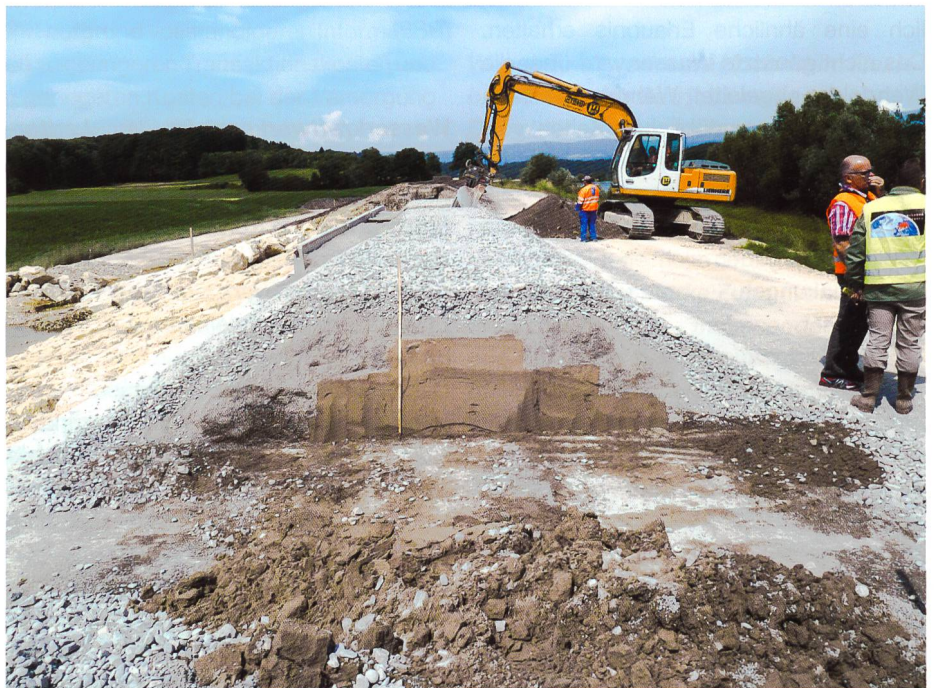
Bild 2. Einbau der erodierbaren Dammkrone als Überlastsicherung (Foto: zvg).
