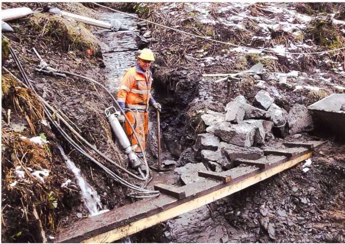
Bild 3. Abbrucharbeiten an einer der Quellfassungen Anfang November 2013.
