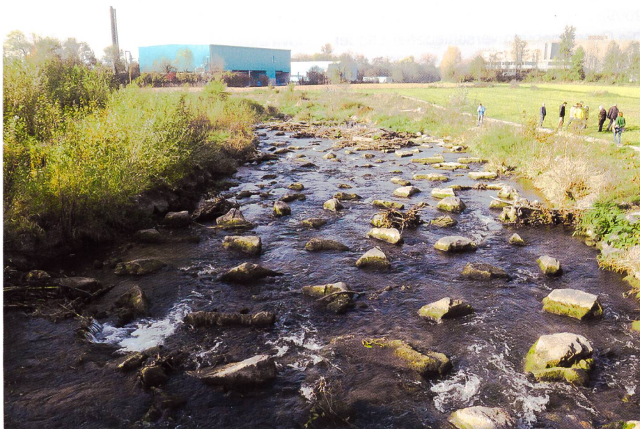
Bild 2. Die aufgelöst strukturierte Rampe an der Wyna bei Suhr Kanton Aargau, CH, wurde auf der Tagungsexkursion besucht (Foto: A. Peter).
