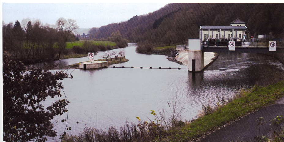
Bild 3. Wasserkraftwerk Unkelmühle an der Sieg NRW, Blick vom Oberwasser. Pilotanlage für den Fischschutz (Fischabstieg) mit drei Rechenfelder mit einem 10 mm Vertikalrechen und Rechenreiniger (Foto: A. Peter).
