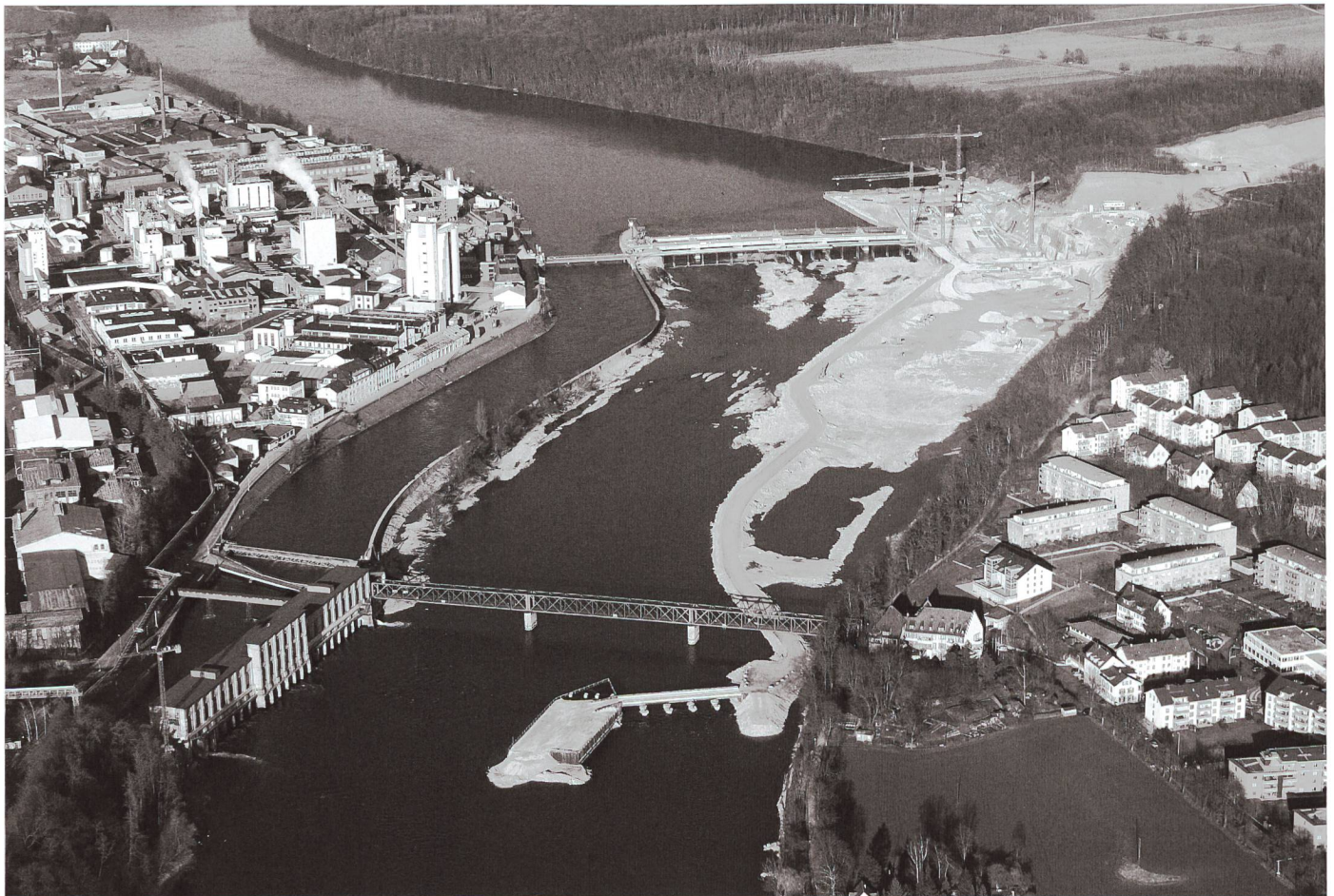
Bild 13. Luftaufnahme der Baustelle für den 2010 abgeschlossenen Neubau des Kraftwerks Rheinfelden; links im Bild noch das 1898 in Betrieb genommene erste Kanalkraftwerk Rheinfelden.
