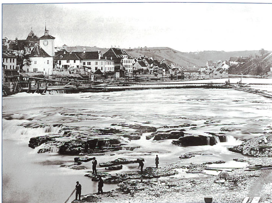
Bild 1. Bauarbeiten am Moserdamm um 1864.
