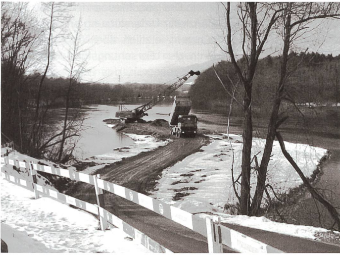
Bild 19a/b. Geschiebeschüttungen in die Aare bei Deitingen; links im Februar 2005, rechts nach dem ersten Hochwasser im April 2005.
