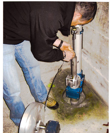
Figure 3. Lecture des instruments de contrôle dans le barrage.
