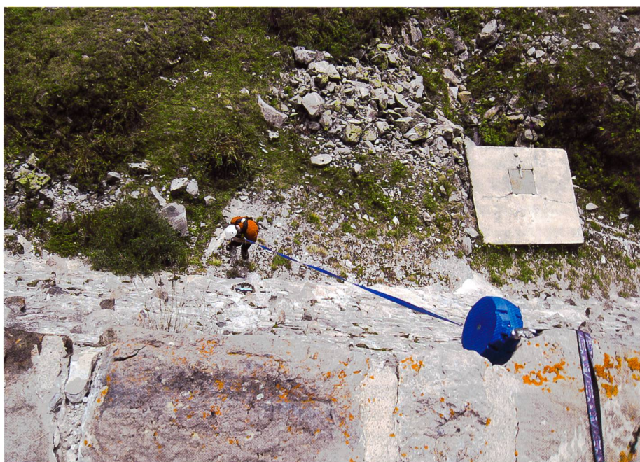
Figure 4. Contrôle des alentours du barrage.
