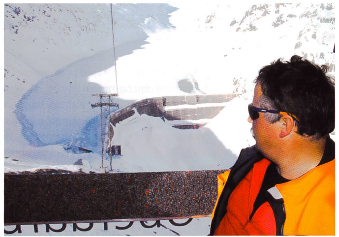
Figure 2. Barrage avec accès par téléphérique.
