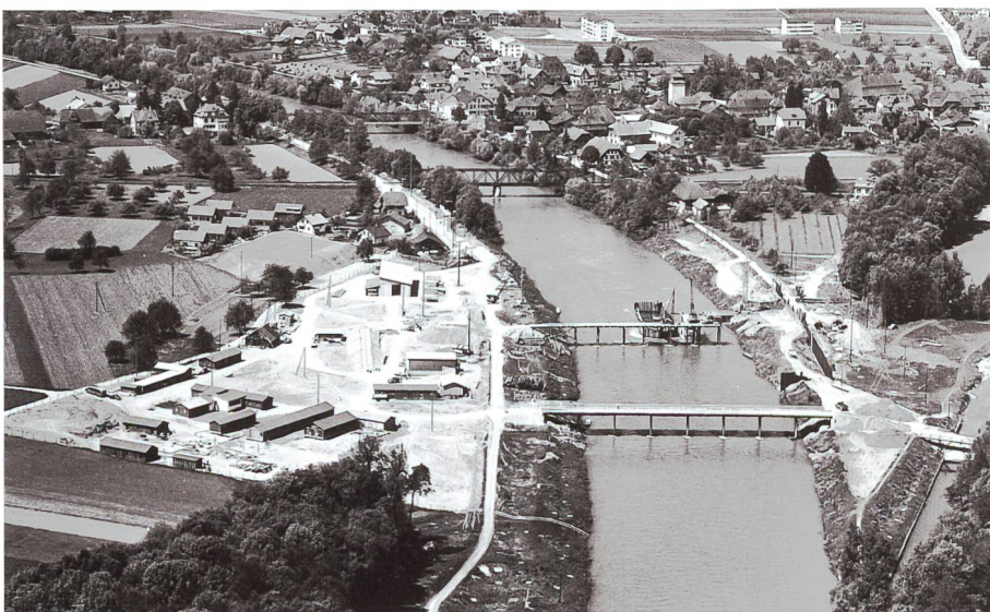
Bild 3. Baubeginn Juni 1963, Wehrpfeiler Nr. 1 (oberer Bildrand: Aarberg, rechter Bildrand: Alte Aare) (Foto: B. Bachmann, Fliegeraufnahmen, Bern).
