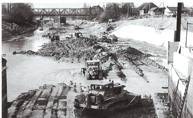
Bild 9. Unterwasserausbaggerung mit trockengelegter Aare (Foto: BKW Energie AG).
