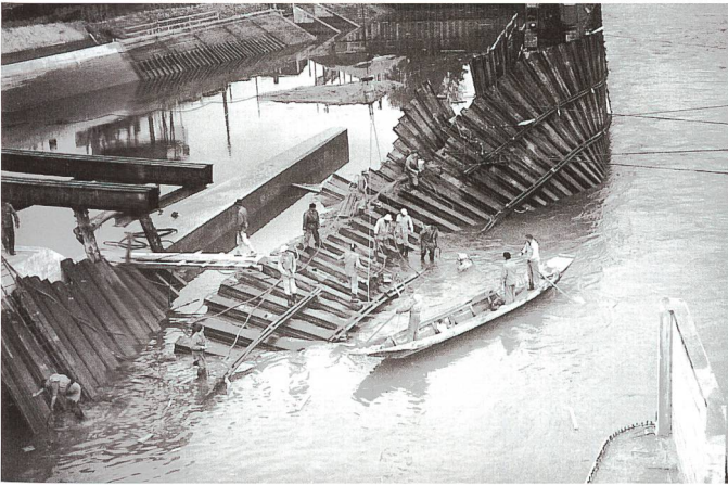
Bild 5. Einsturz Fangdamm am 19. Mai 1965 (Foto: BKW Energie AG).
