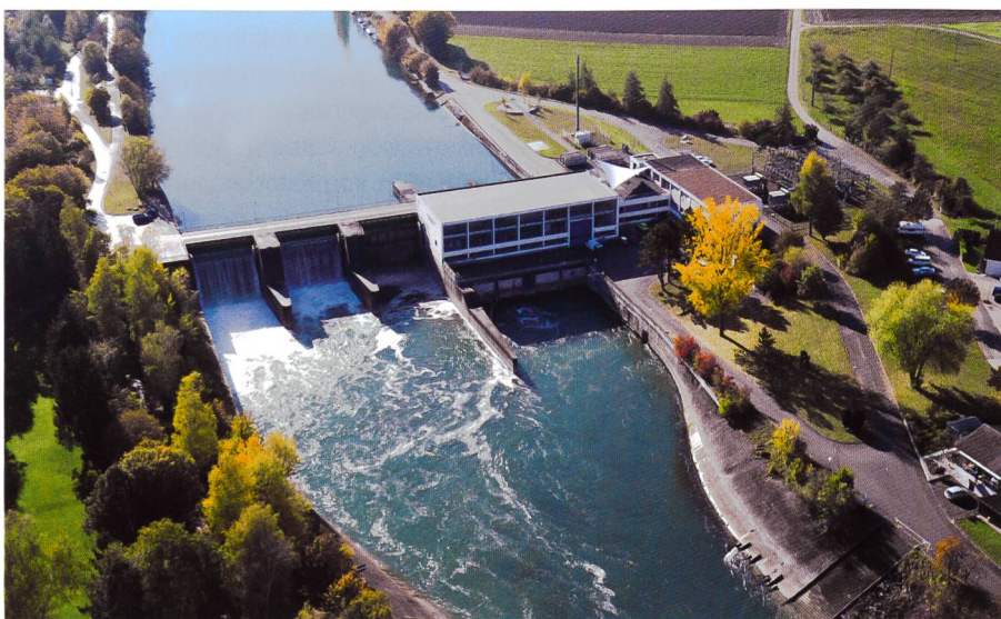
Bild 1. Gesamtübersicht Kraftwerk Aarberg.
