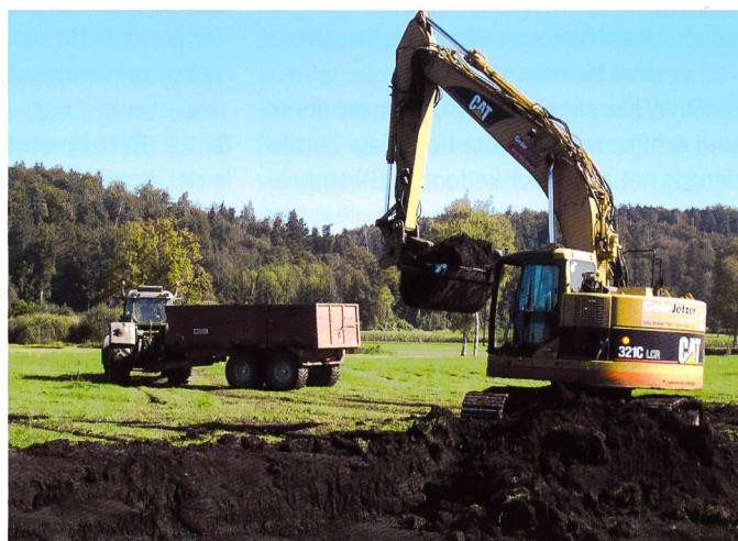
Bild 2. Abtrag des Torfbodens mit Raupenbagger, September 2013.
