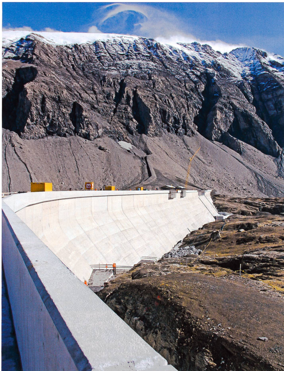
Bild 2. Die Staumauer November 2014.
