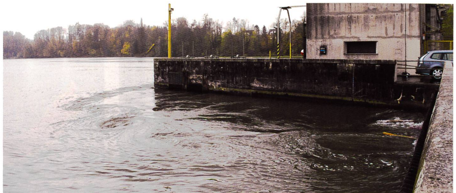
Bild 2. Strömungsablösung am Trennpfeiler (Bild VAW).
