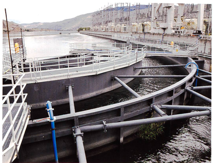
Bild 13. Bypasseinrichtung am Rocky Reach Dam mit 85% Leitwirkung und nahezu 100% Überlebensrate. (Foto: VAR).
