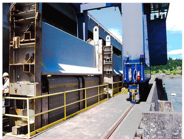
Bild 11. Element mit umlaufendem Rechen (Travelling Screen) an der Oberfläche am Bonneville Dam (Foto: VAR).
