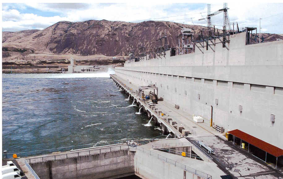
Bild 5. John Day Dam, Leistung: 2.1 Gigawatt, Fallhöhe: 34 m, Länge Staustrecke: 123 km (Foto: VAR).
