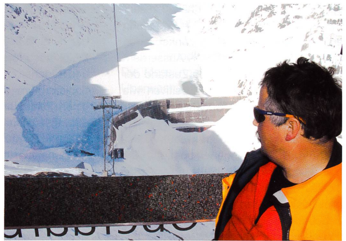
Bild 2. Talsperre mit Seilbahnerschliessung.
