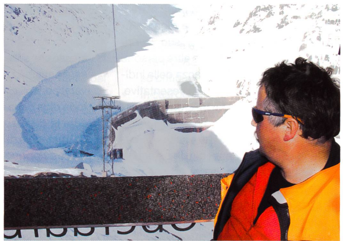
Figura 2. Diga con l'accesso via teleferica.
