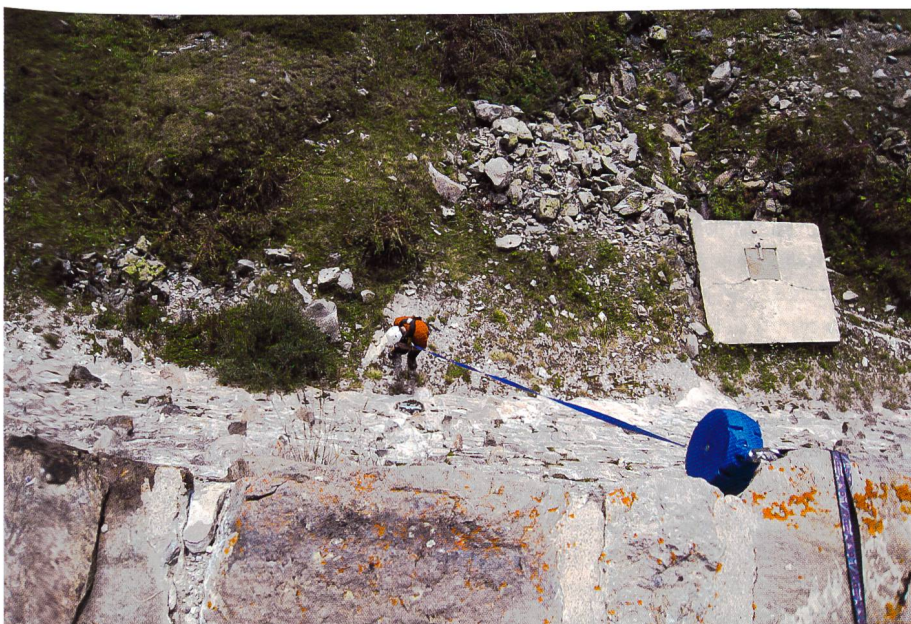
Bild 4. Kontrolle der Talsperrenumgebung.
