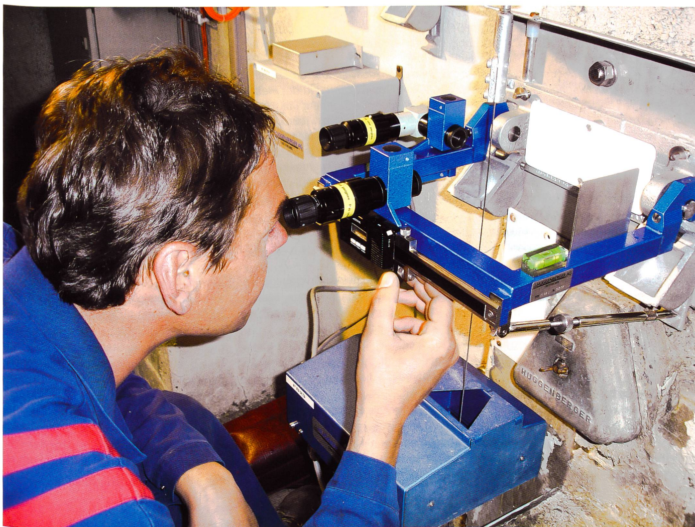
Talsperrenwärter beim Ablesen der Lotmessung / Custode diga mentre misura la posizione del pendolo.
