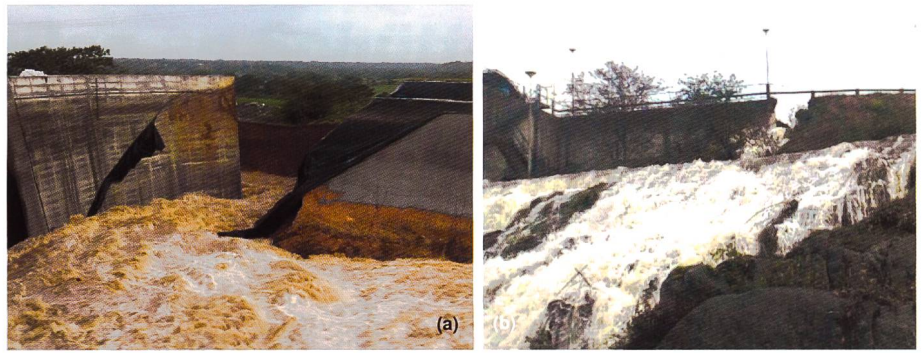
Bild 3. Beispiele von Dambrüchen der vergangenen Jahre: (a) Versagen eines homogenen Schüttdammes in Panama (Messerklinger, 2014) (b) Dambruch eines gezonten Schüttdammes in Schweden (Ekström, 2012).
