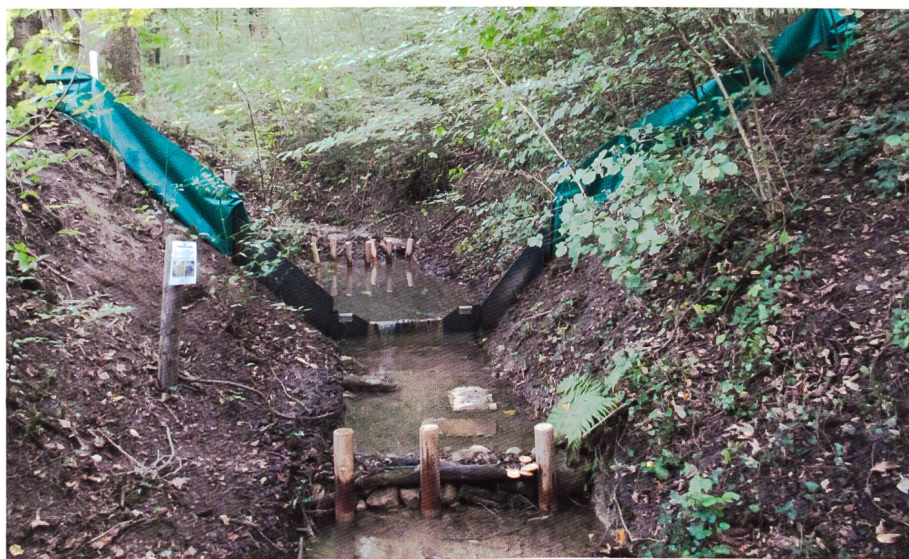
Bild 2. Krebsperre in Winterthur mit ausgebauter Landbarriere.
