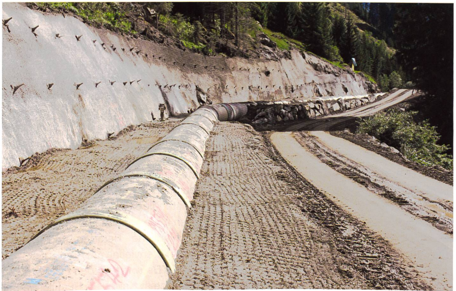
Bild 2. Die neu erdverlegte Druckleitung vor der Überdeckung (Foto: SWV/Pfa).
