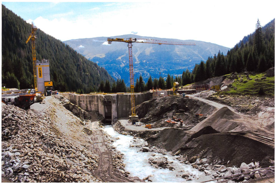
Bild 1. Die inzwischen fertiggestellte Erhöhung der Staumauer Barcuns während des Baus (Foto: SWV/Pfa).
