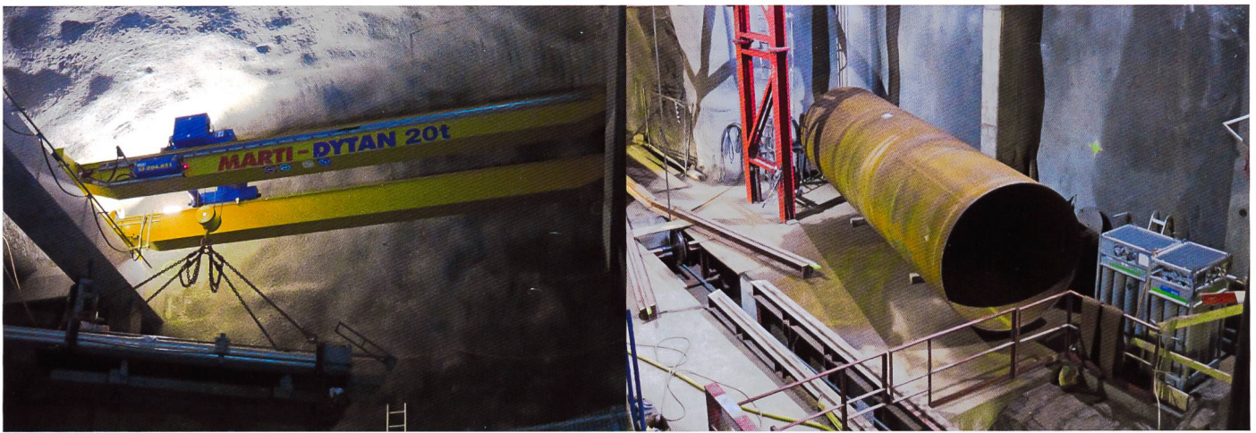
Bild 1. Der 20 t Zweiträger-Laufkran bringt die neuen Druckrohre in den Stollen ein.
