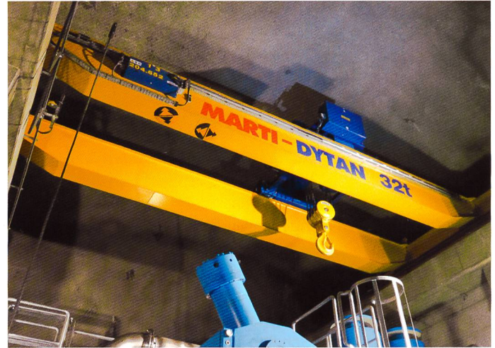
Bild 3. Der 32-t-Laufkran hilft beim Einbringen der schweren Drosselklappenteile.
