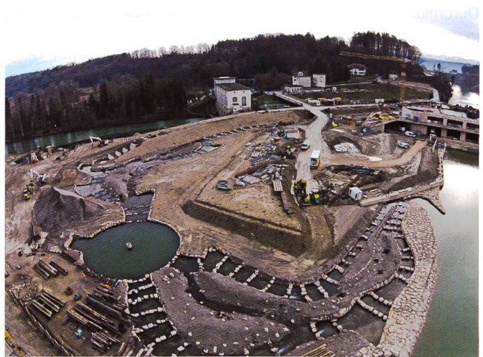
Bild 7. Sicht auf Umgehungsgerinne (Drohnenaufnahme von Januar 2015) (Quelle: Geoplanteam, Nidau).
