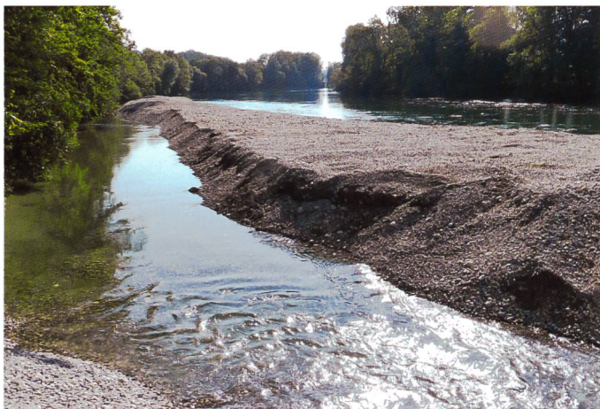
Bild 6. Durch Kiesschüttungen in den Fluss – wie hier bei Aarwangen (BE) im September 2013 – werden die durch Wehranlagen von Kraftwerken und Geschiebesammlern verursachten Geschiebedefizite teilweise ausgeglichen (Bild: Daniel Bernet, Fischereinspektorat, Kanton Bern).
