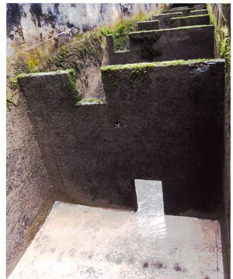
Bild 9. Die Dimensionierung dieser 1968 erstellten Fischaufstiegsanlage beim Wasserkraftwerk Bannwil (BE) kann den Ansprüchen der grösseren Wanderfische nicht genügen. Für die Zielarten Lachs und Barbe ist der Beckenpass – mit seinen Schlupflöchern und Kronenausschnitten – zu klein und muss deshalb saniert werden (Bild: Daniel Bernet, Fischereinspektorat, Kanton Bern).
