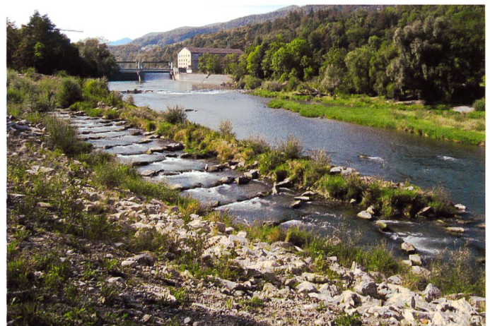
Bild 7. Dank diesem 660 Meter langen Umgehungsgewässer stellt die Staustufe des Kraftwerks Rupperswil-Auenstein (AG) für aufsteigende Fische seit 2006 kein unüberwindbares Hindernis mehr dar (Bild: Departement Bau, Verkehr und Umwelt des Kantons Aargau).
